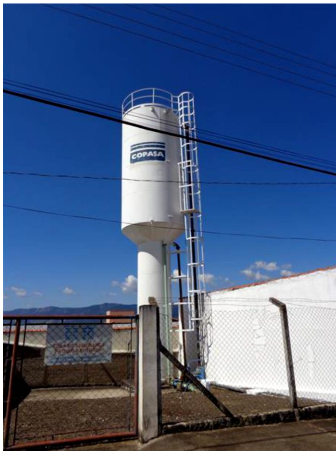
Figura 31: Vista do REL 10 com 50 m 3 no Jd. Alvorada Fonte: ARSAE (2019)
