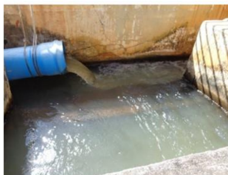
Figura 13: Canal de chegada de água da ETA Fonte: ARSAE (2019)
