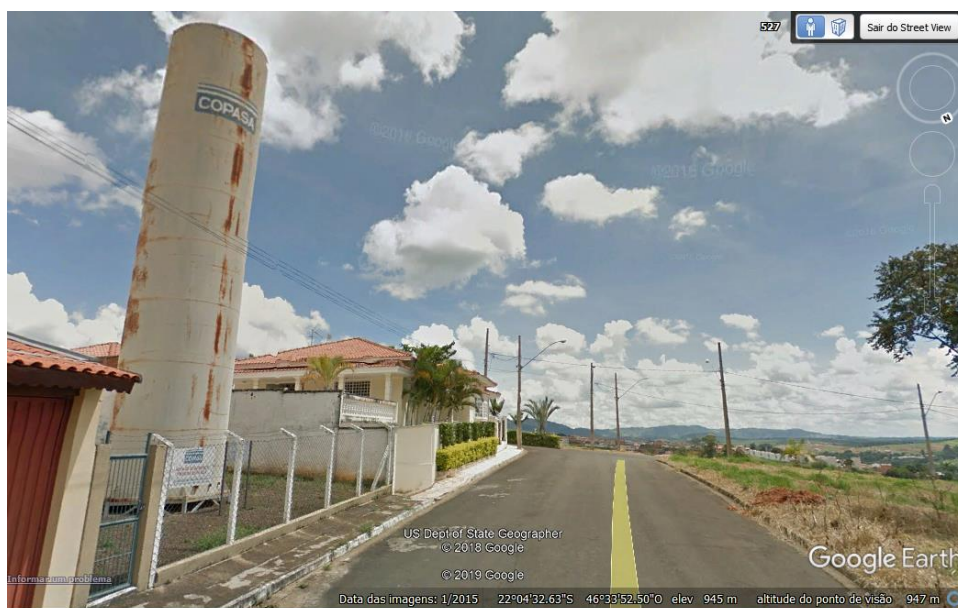
Figura 35: Vista externa Reservatório Elevado do Jd. Panorama Fonte: Google Earth/Street View (01/2015)
