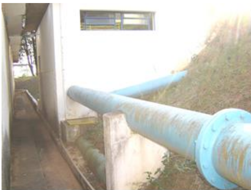
Figura 17: Vista externa da EAF Fonte: COPASA (2006)
