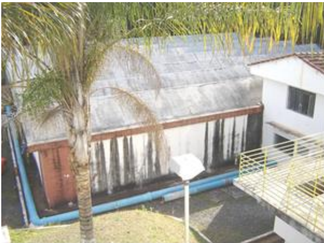
Figura 21: Vista do RAP 1 com 1.935 \text{ m}^3
