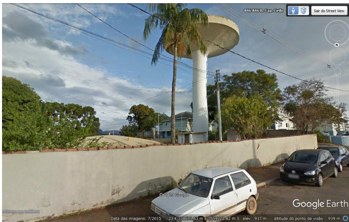
Figura 24: Vista do REN 5 e reservatório elevado (desativado)
