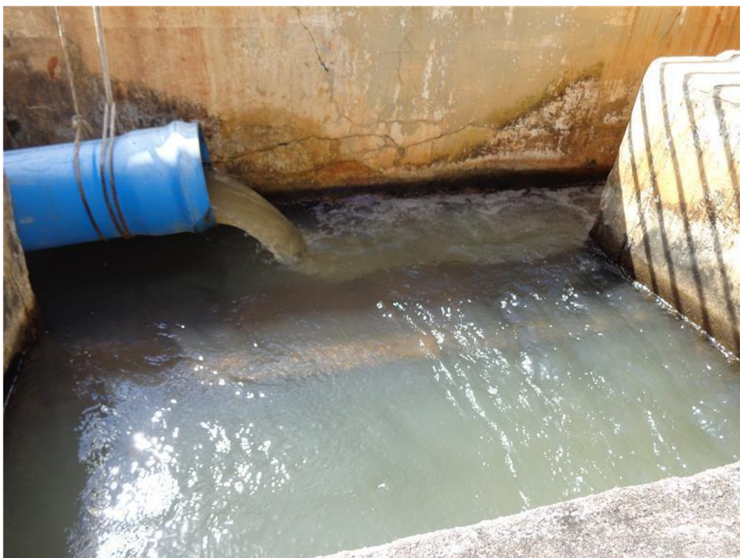
Figura 13: Canal de chegada de água da ETA Fonte: ARSAE (2019)
