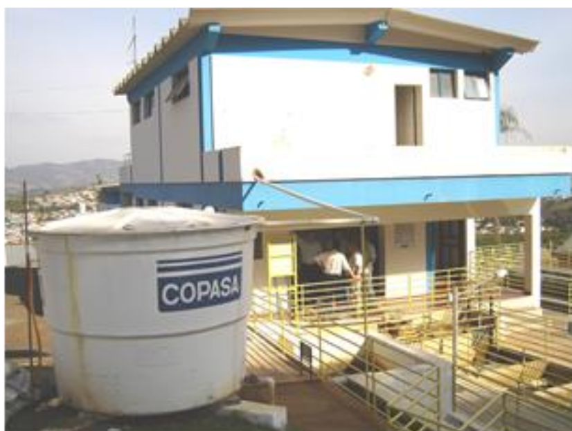
Figura 15: Vista externa da Casa de Química Fonte: COPASA (2006)
