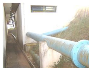
Figura 17: Vista externa da EAF Fonte: COPASA (2006)
