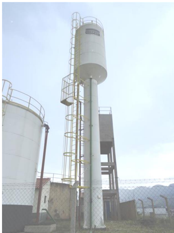
Figura 34: Vista externa dos Reservatórios Elevados do Jd. Mirante Fonte: Google Earth/Street View (01/2015)
