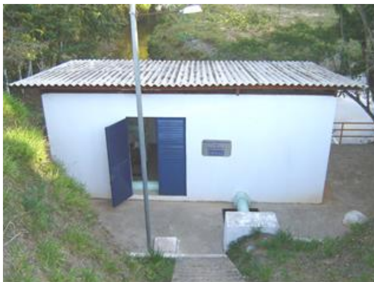
Figura 7: EAB de Baixo Recalque (Externa) Fonte: COPASA (2006)
