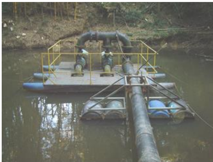
Figura 1: Detalhe da balsa existente
